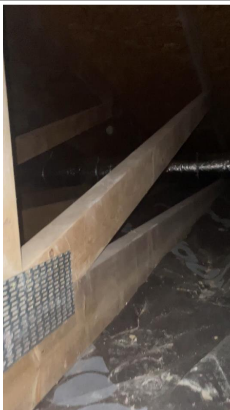
a.7 widok więzara dachowego – połąć pod kątem ok. 15°, strona południowa
