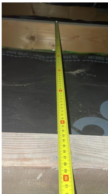
a.14 widok więzara dachowego – rozstaw więzarów dachowych
