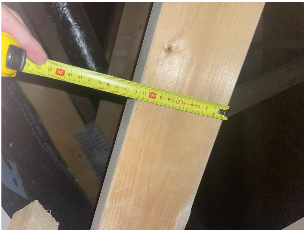
a.11 widok więzara dachowego – wysokość krzyżulca
