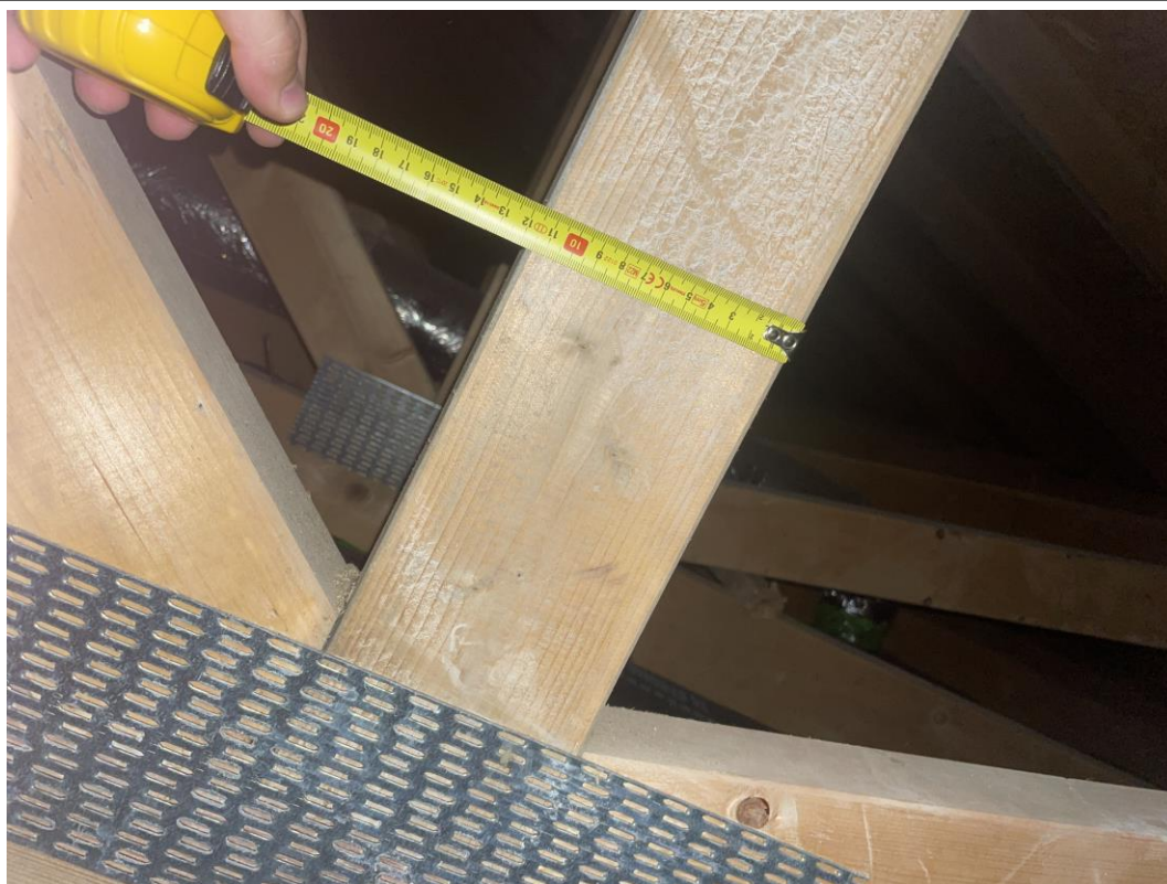
a.13 widok więzara dachowego – wysokość słupka
