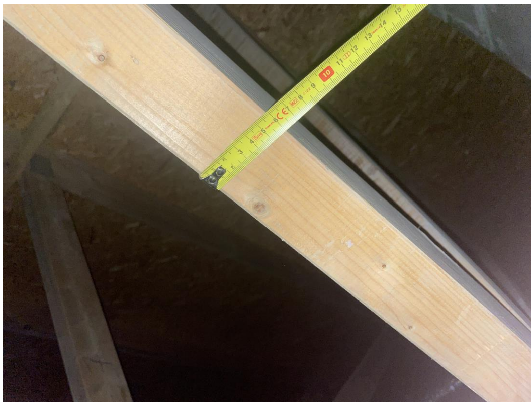
a.12 widok więzara dachowego – szerokość krzyżulca
