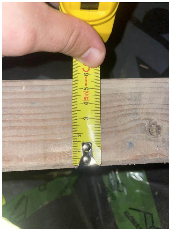
a.10 widok wiązara dachowego – szerokość pasa dolnego
