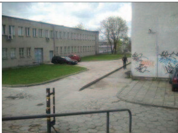
Fot.9 – droga końcowy odcinek drogi pożarowej do budynku DS.-1. Usunąć środkowy krawężnik utrudniający dojazd.
