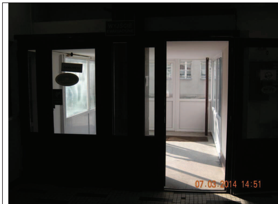
Fot. 5 – drzwi wyjściowe z budynku dwie pary o szerokości w świetle 0.91 m i 0,79 m wobec wymaganej szerokości co najmniej jednych drzwi minimum 1,2 m (§68 ust.1) oraz jednych o szerokości nie mniejszej niż 1,8 m (§256 ust.6 pkt.4 WT); jedno skrzydło nie otwierane na zewnątrz.
