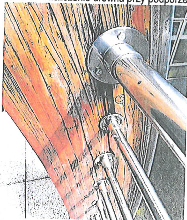
Fot nr 10 Rozwarstwienie drewna klejonego.
