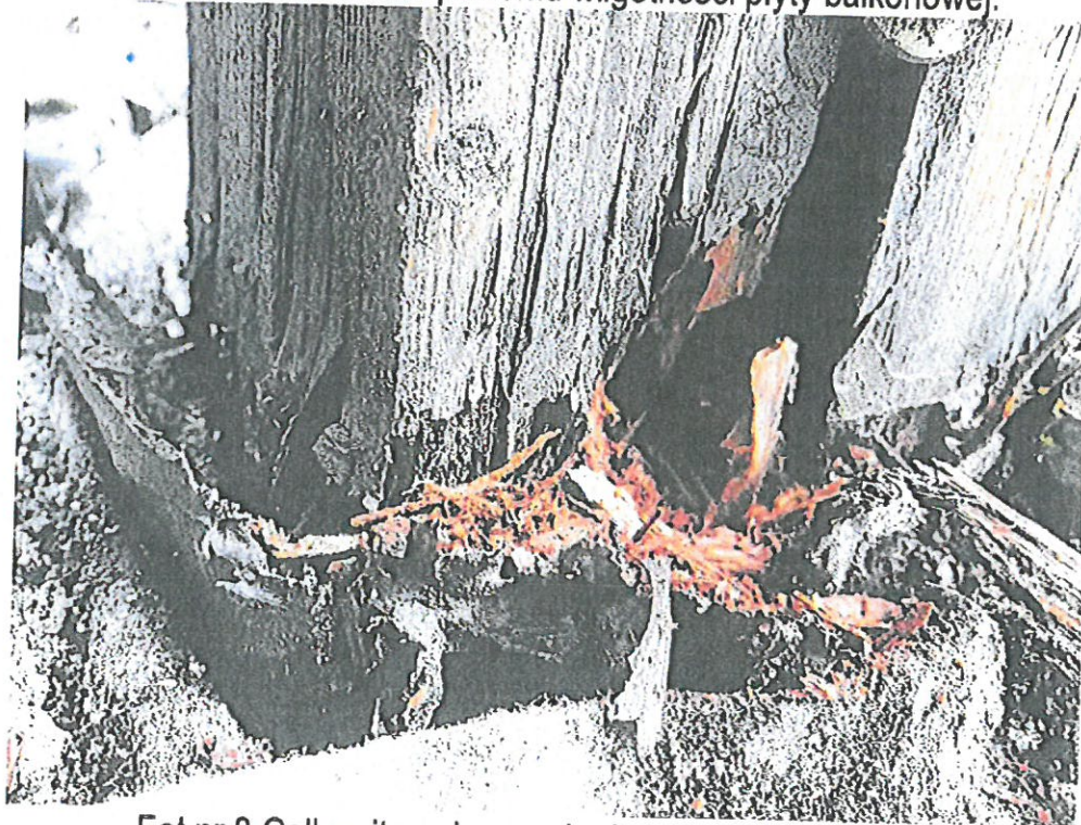
Fot nr 8 Całkowite zniszczenie drewna przy podporze.
