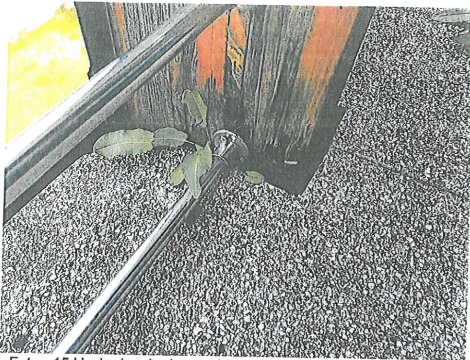
Fot nr 15 Uszkodzenie drewna klejonego w strefie przypodporowej.
